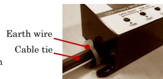
【Installation by cable ties】
